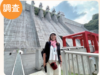
ハッ場ダム(群馬県)を現地調査
